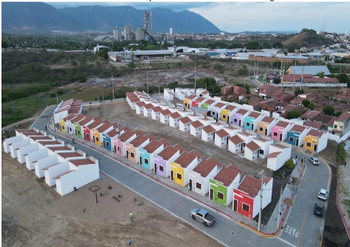
FIGURA 3. Foto do conjunto habitacional Padre Palhano Village
