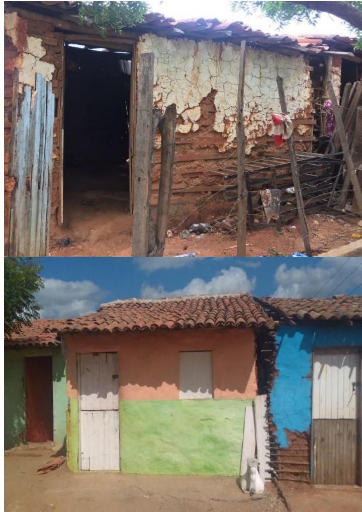
FIGURAS 4 E 5. Casas de taipa existentes na poligonal onde foi construído o conjunto habitacional
