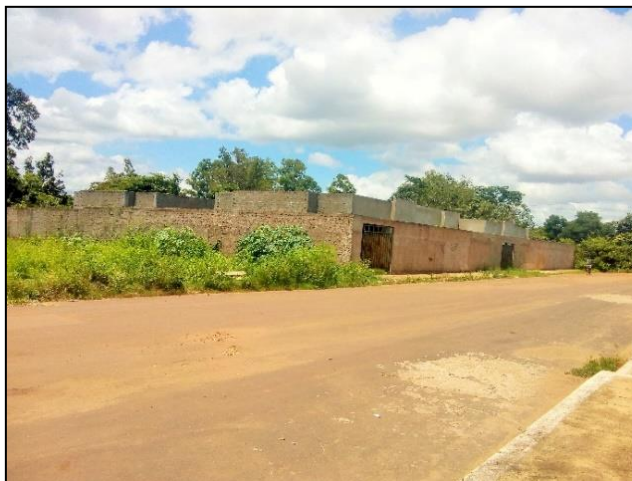
Figura 4: foto de creche com obras paralisadas
