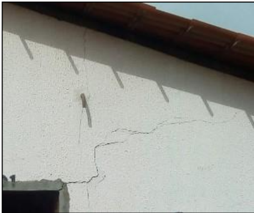
Figura 2: Foto Estrutura de moradia
