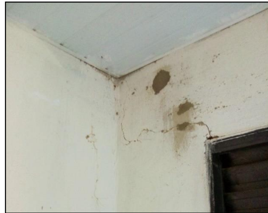
Figura 3: Foto Estrutura de moradia
